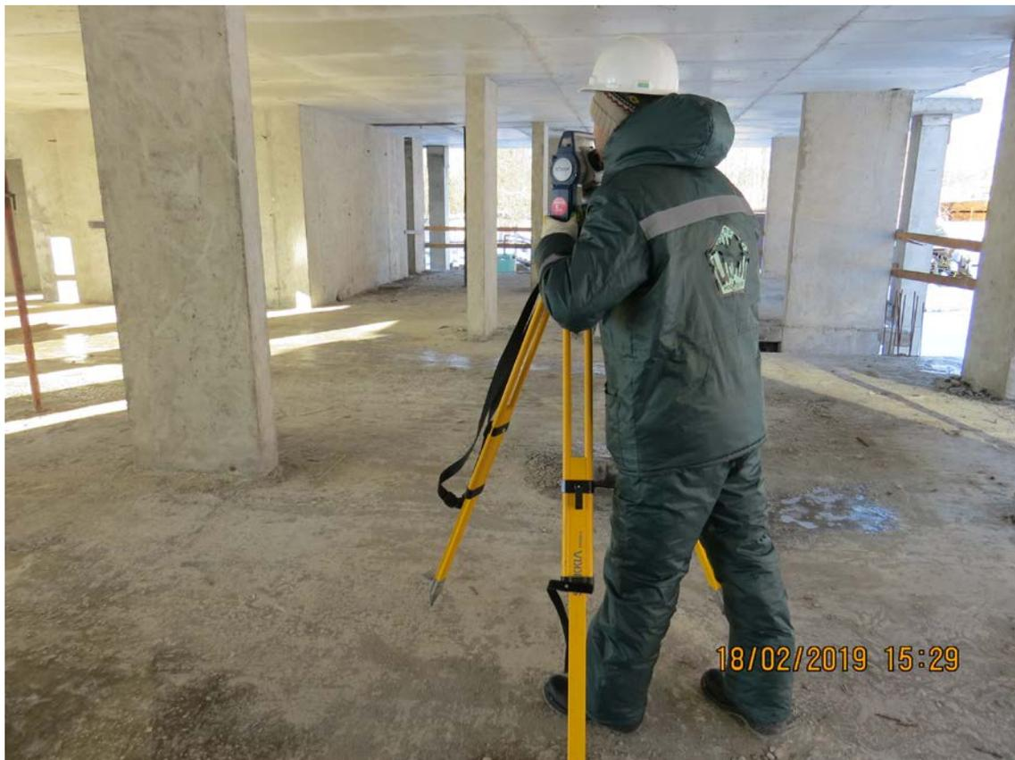
**Рис. 2.7. Геодезические наблюдения электронным тахеометром Sokkia CX-105**
