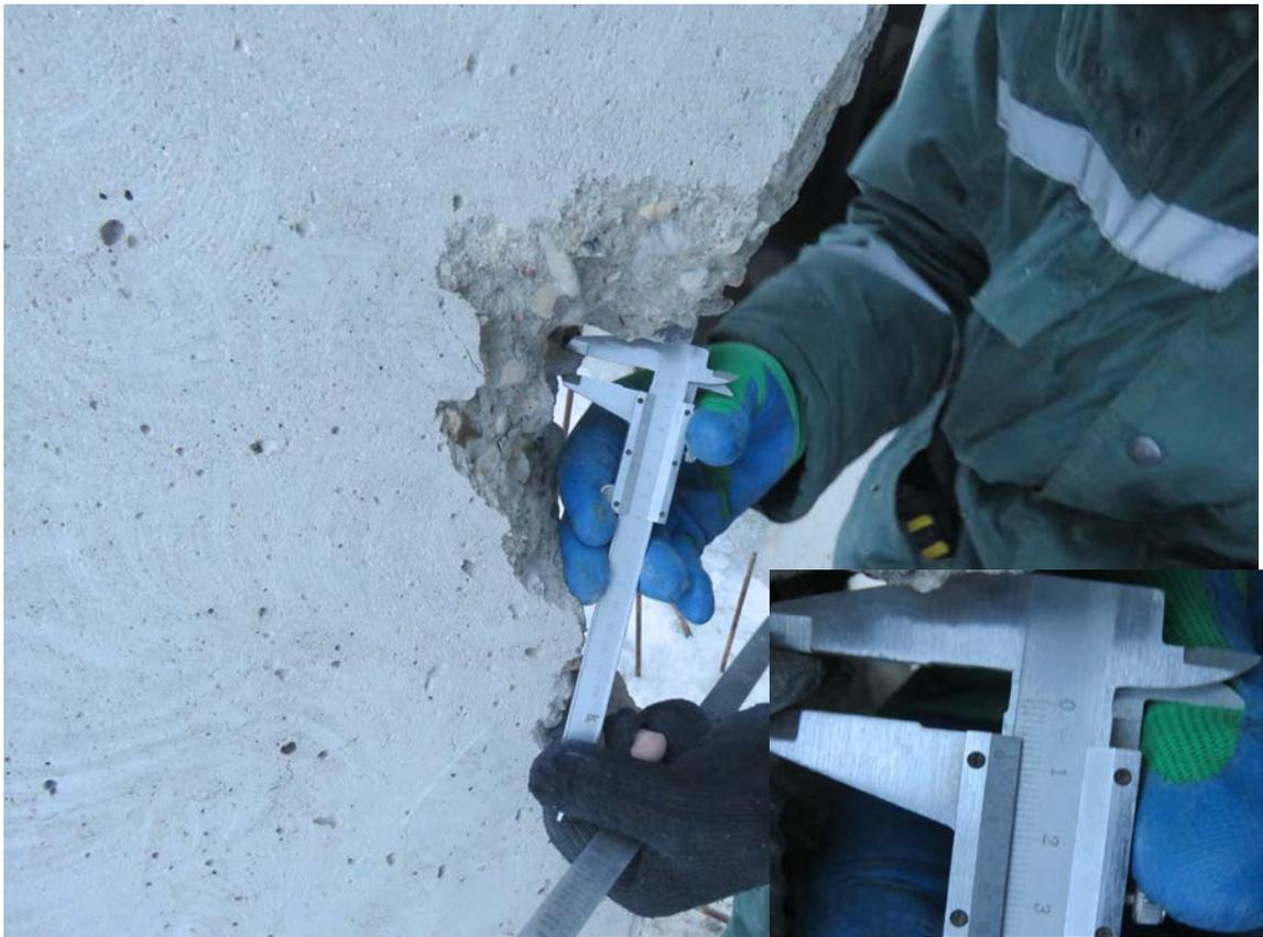
**Рис. 3.2.17. Замер диаметра горизонтального арматурного стержня в монолитной колонне в уровне подвального этажа в осях 26/1/М/1-Н/1**
