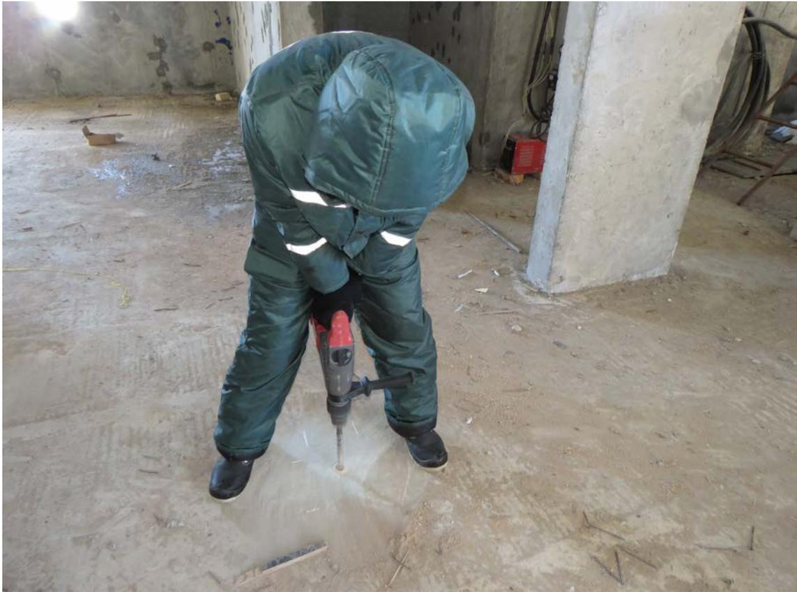
**Рис. 4.2.1. Сверление отверстия в монолитной железобетонной фундаментной плите в осях В/1-Г/1/19/1-20/1**
