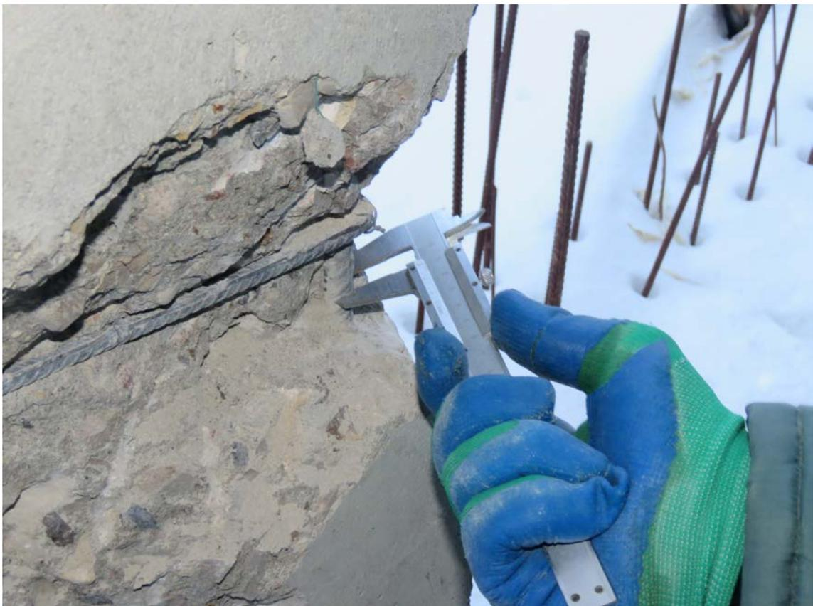
**Рис. 3.2.16. Замер диаметра вертикального арматурного стержня в монолитной колонне в уровне подвального этажа в осях 26/1/М/1-Н/1**
