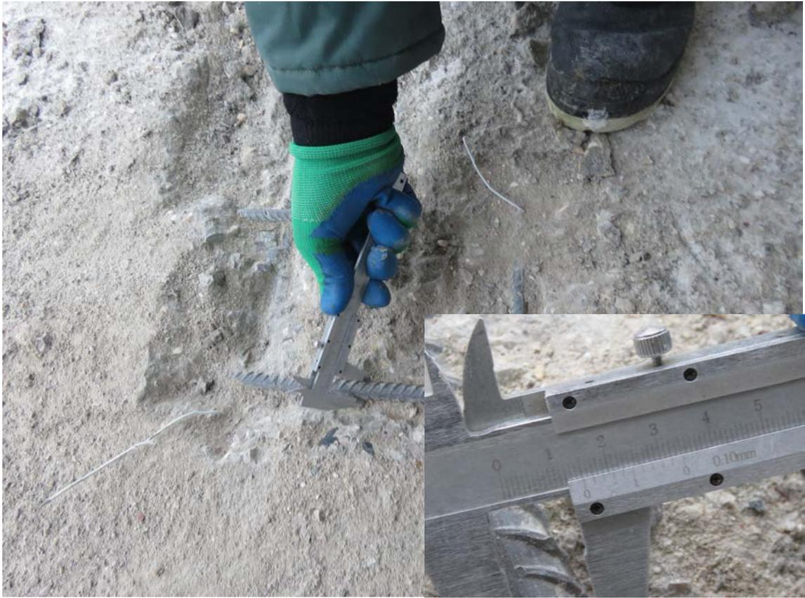
**Рис. 3.3.7. Замер диаметра арматурного стержня плиты перекрытия первого этажа в осях 9/1-10/1/Р/1.1**
