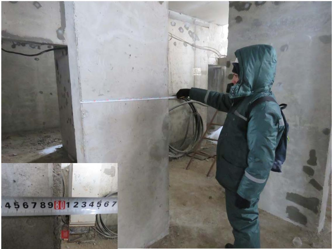
**Рис. 2.1. Замер сечение монолитного железобетонного пилона подвального этажа**
