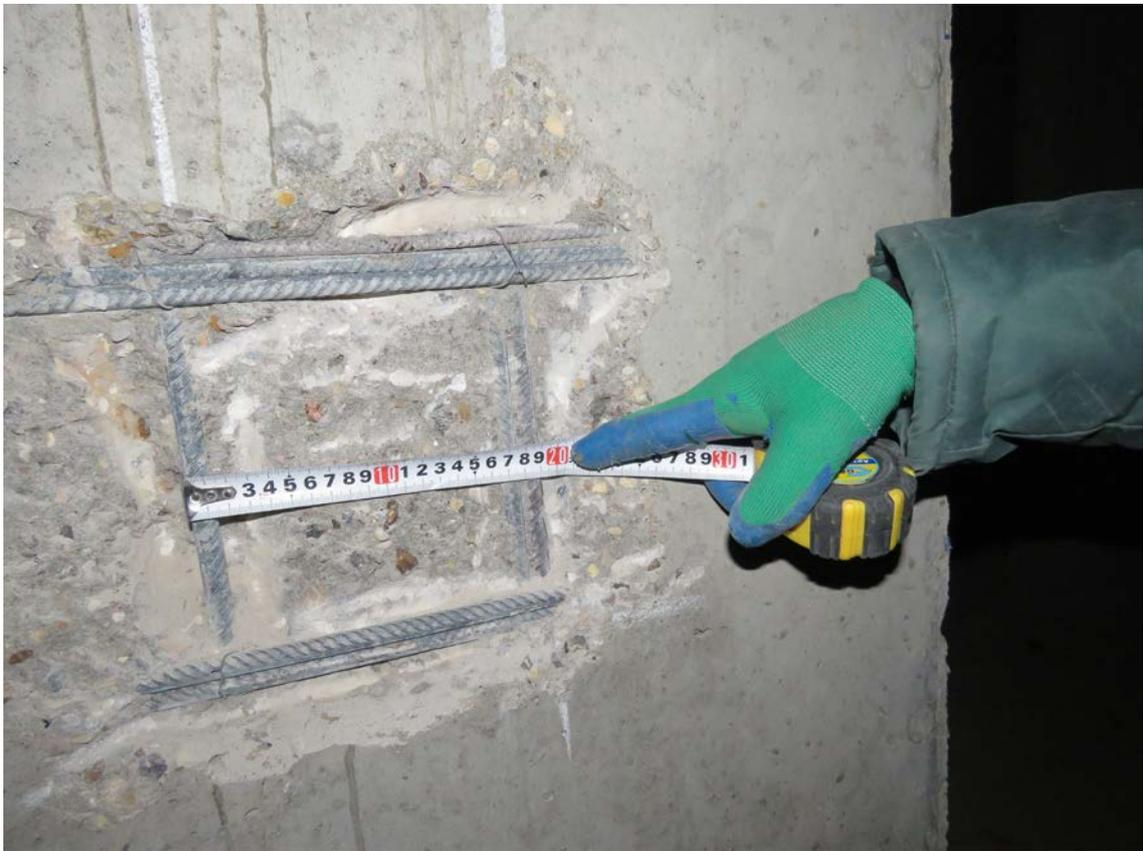
**Рис. 3.2.3. Замер шага арматуры в монолитном пилоне подвального этажа в осях 4/3/Г/3**
