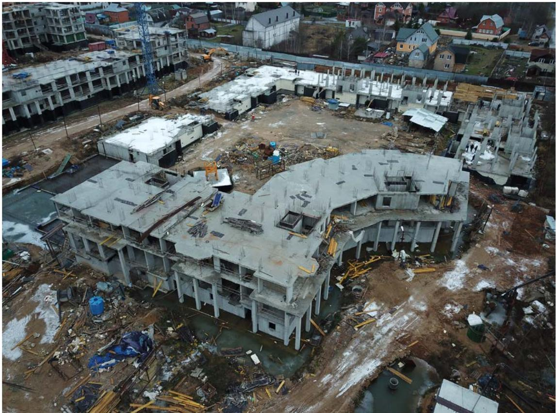
**Рис.3.6.1. Общий вид смонтированных конструкций здания. Отсутствие ограждающих конструкций, а также конструкций покрытия и кровли**
