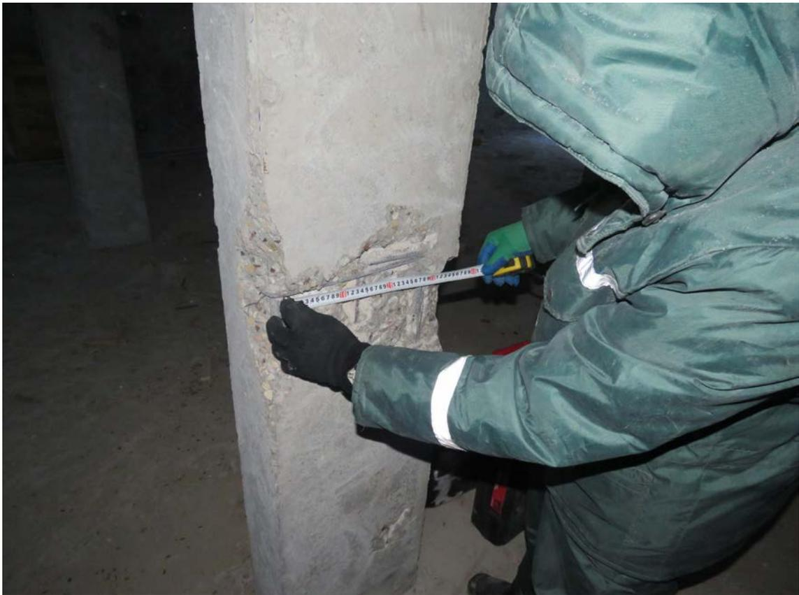
**Рис. 3.2.5. Замер шага арматуры в монолитном пилоне подвального этажа в осях 22/1-23/1/Г/1**
