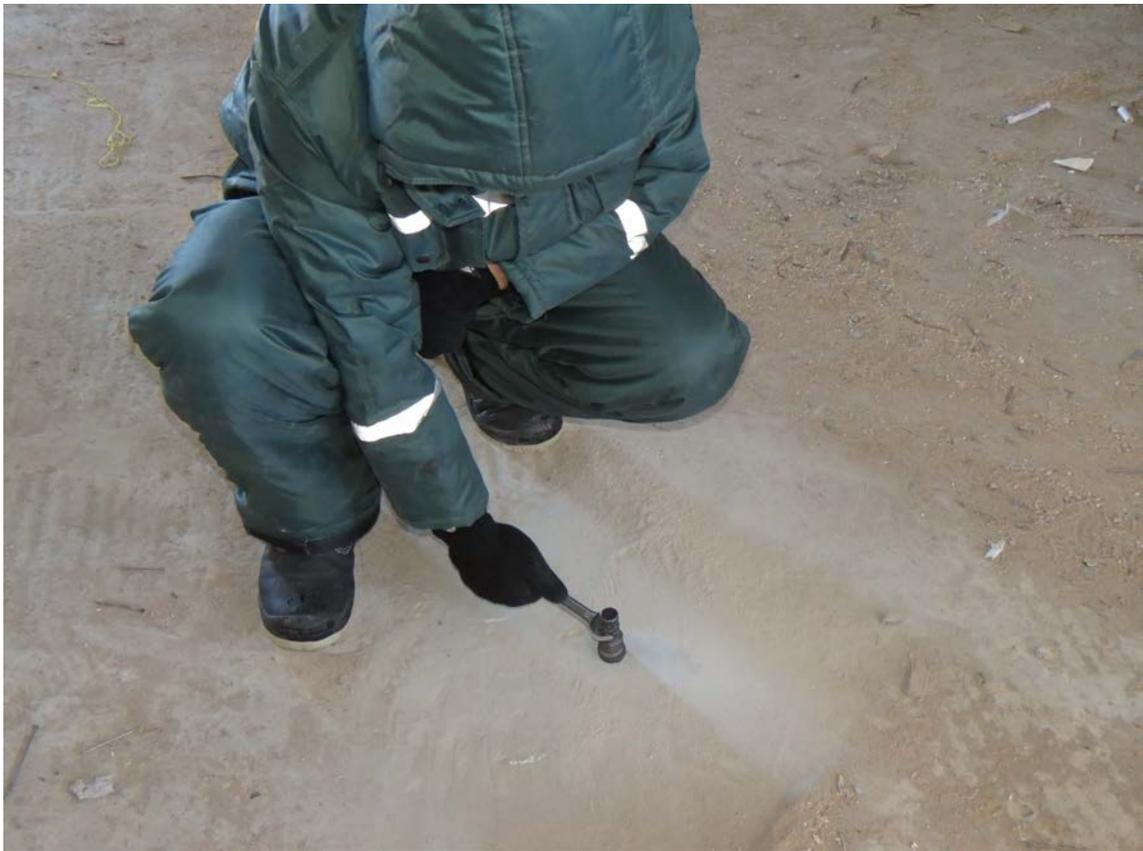
**Рис. 4.2.3. Установка анкерного устройства и тяги в отверстии монолитной железобетонной фундаментной плиты в осях В/1-Г/1/19/1-20/1**
