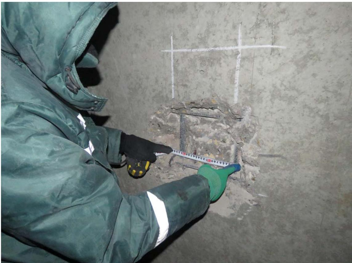
**Рис. 3.2.4. Замер шага арматуры в монолитном пилоне подвального этажа в осях 31/2/К/2-Л/2**
