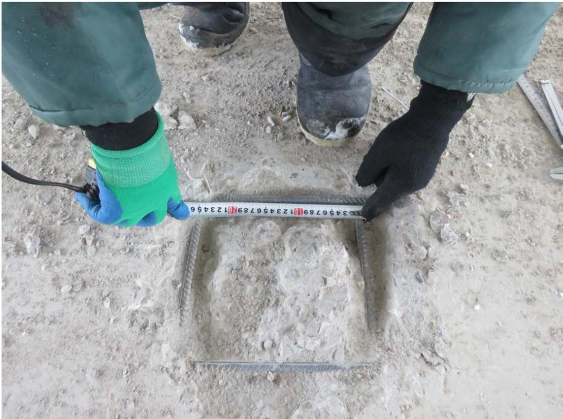
**Рис. 3.3.3. Замер шага верхнего армирования плиты перекрытия первого этажа в осях 9/1-10/1/С/1.1-Х/1.1**
