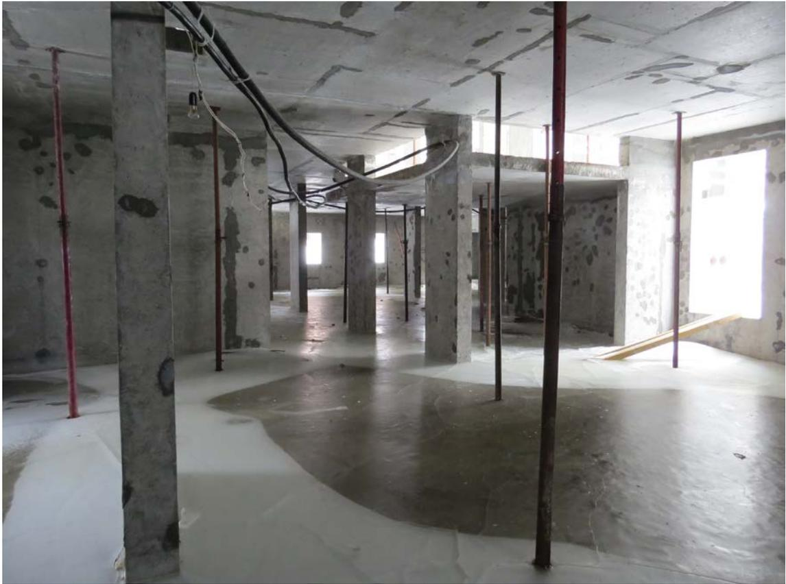
**Рис. 3.1.15. Скопление воды, наледь до 200 мм на поверхности фундаментных плит в секции № 10**
