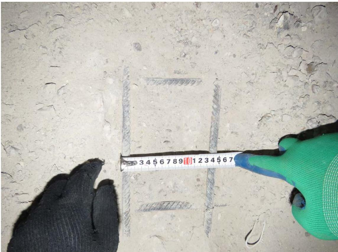
**Рис. 3.1.8. Замер шага верхнего армирования фундаментной плиты между осями 23/1-26/1 и А/1-Б/1**
