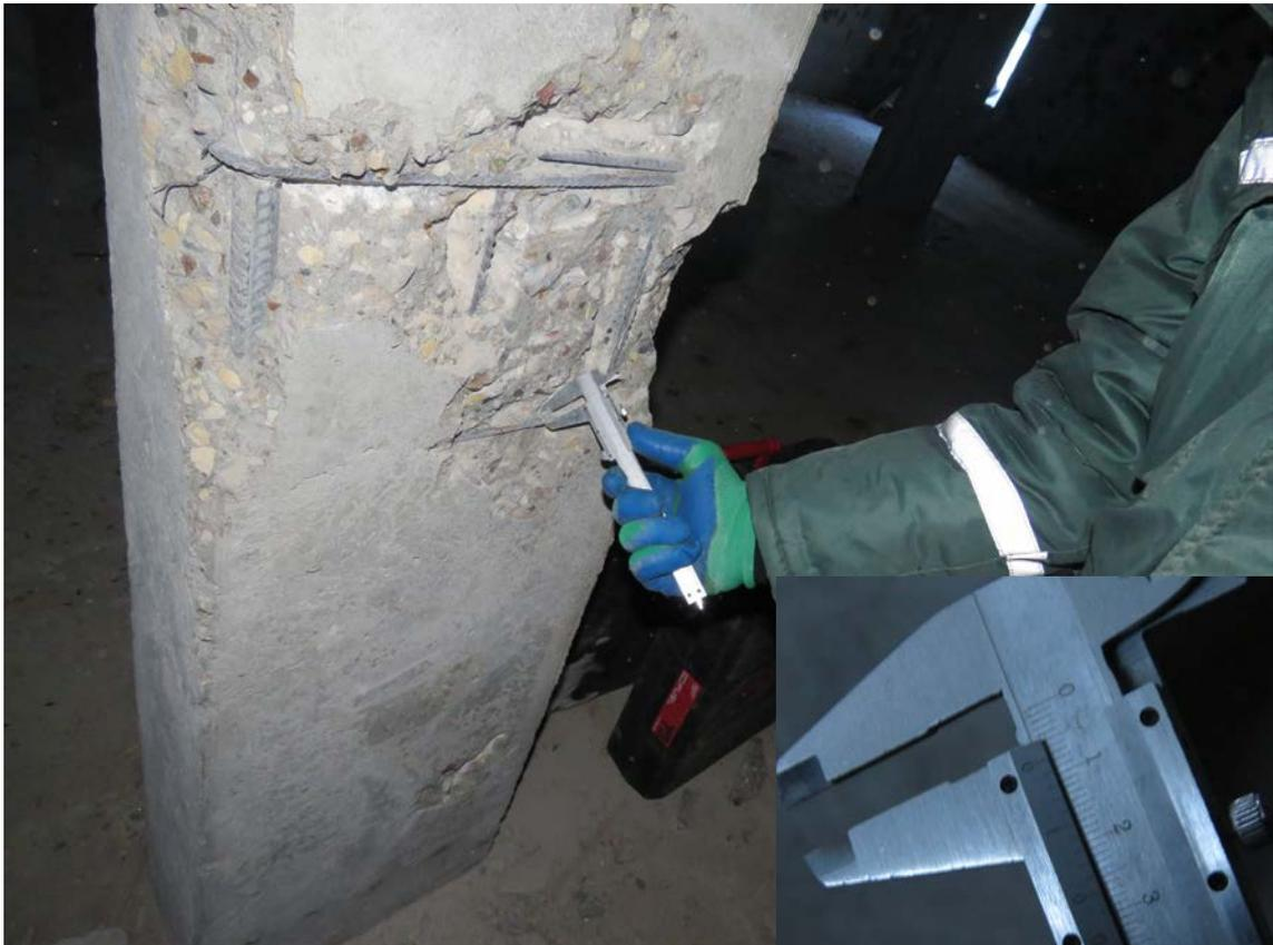
**Рис. 3.2.8. Замер диаметра арматурного стержня в монолитном пилоне подвального этажа в осях 22/1-23/1/Г/1**
