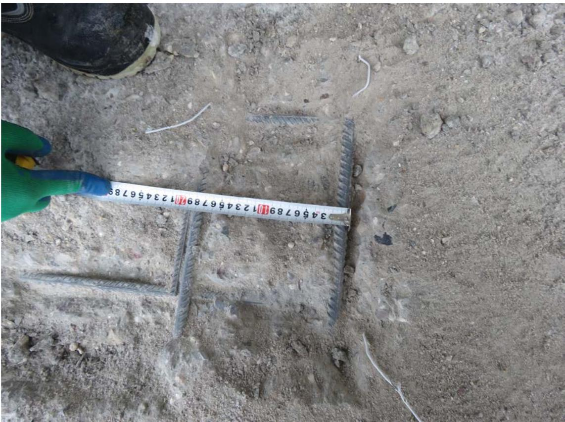
**Рис. 3.3.6. Замер шага верхнего армирования плиты перекрытия первого этажа в осях 9/1-10/1/Р/1.1**
