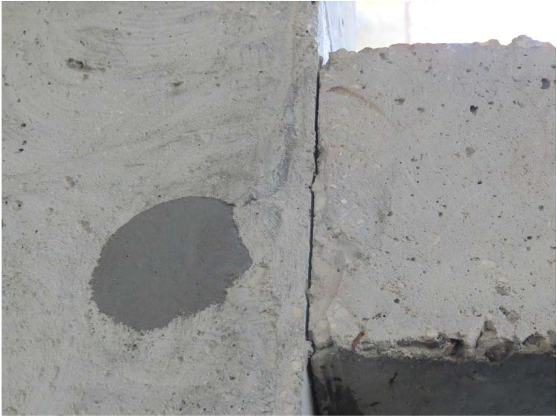
**Рис. 3.3.12. Участок отсутствия сопряжения монолитной плиты перекрытия с пилоном в осях 6/3/В/4**
