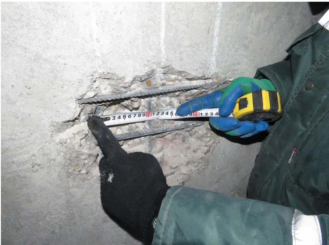
**Рис. 3.2.10. Замер шага арматурных стержней в монолитной стене подвального этажа в осях 4/1/У/1.2-Х/1.2**
