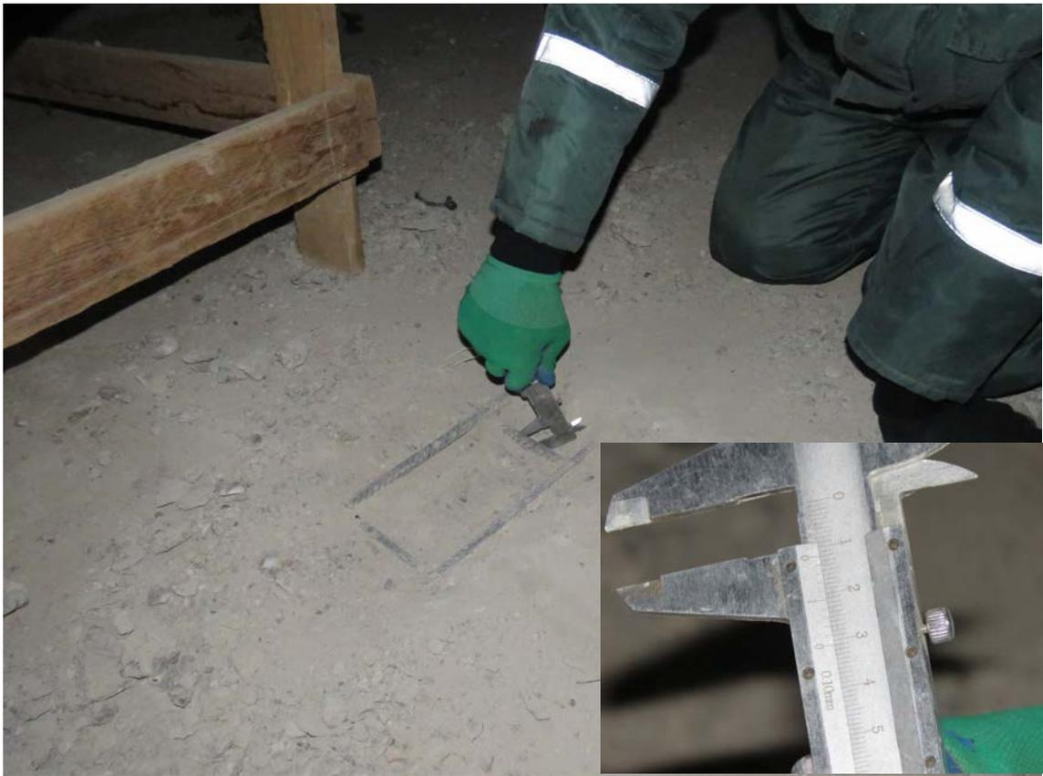
**Рис. 3.1.11. Замер диаметра арматурного стержня фундаментной плиты между осями 23/1-26/1 и А/1-Б/1**
