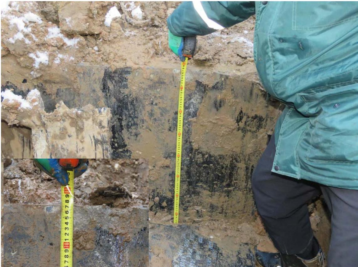
**Рис. 3.1.3. Замер толщины фундаментной плиты с защитной цементно-песчаной стяжкой в осях 1/2/В/3 (770 мм)**
