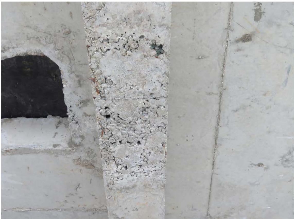
**Рис. 3.3.10. Участок нарушения технологии бетонирования**
