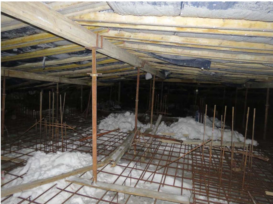
**Рис. 3.1.2. Общий вид арматурного каркаса секции № 8**
