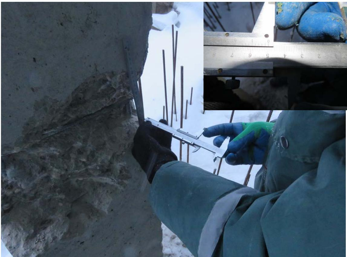
**Рис. 3.2.18. Замер защитного слоя бетона в монолитной колонне в уровне подвального этажа в осях 26/1/М/1-Н/1**
