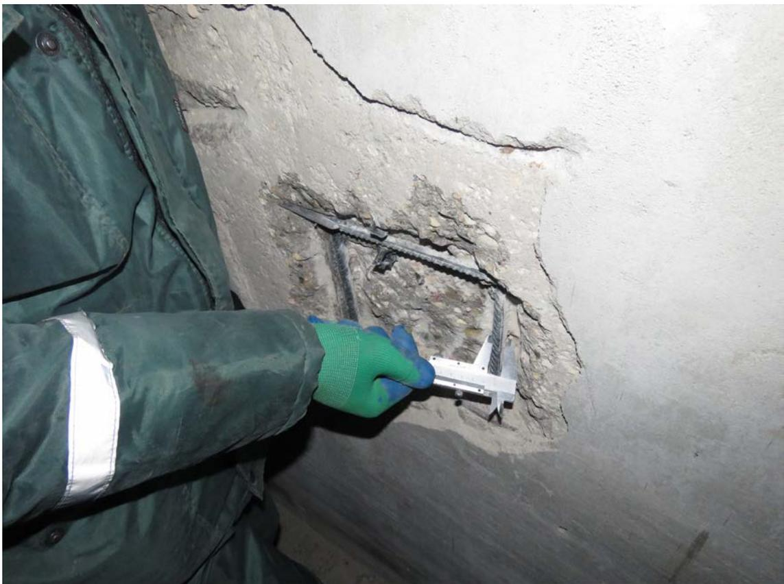
**Рис. 3.2.12. Замер диаметра арматурного стержня монолитной стены подвального этажа в осях 7/2-8/2/АИ/2**
