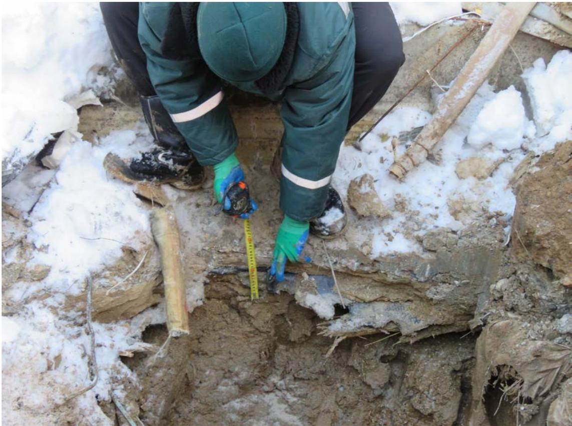
**Рис. 3.1.5. Замер толщины бетонной подготовки под фундаментной плитой в осях 26/1/А/1-Б/1 (90 мм)**
