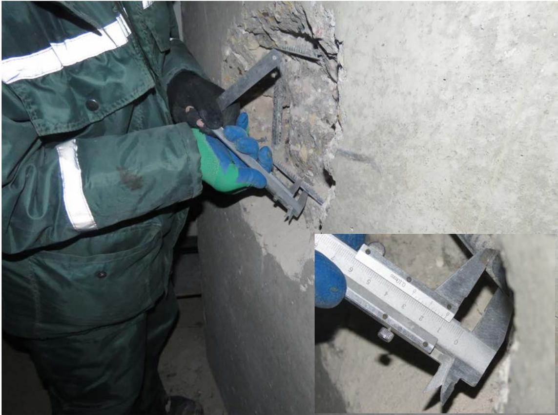
**Рис. 3.2.7. Замер диаметра арматурного стержня в монолитном пилоне подвального этажа в осях 31/2/К/2-Л/2**
