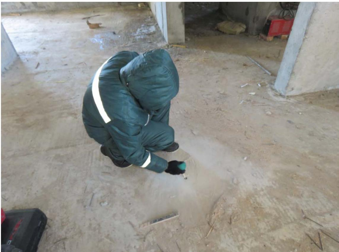
**Рис. 4.2.2 . Продувка отверстия от пыли в монолитной железобетонной фундаментной плите в осях В/1-Г/1/19/1-20/1**
