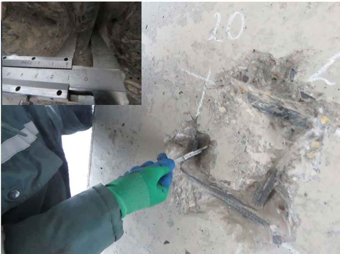
**Рис. 3.2.6. Замер диаметра арматурного стержня в монолитном пилоне второго этажа в осях 9/1/С/1.1**
