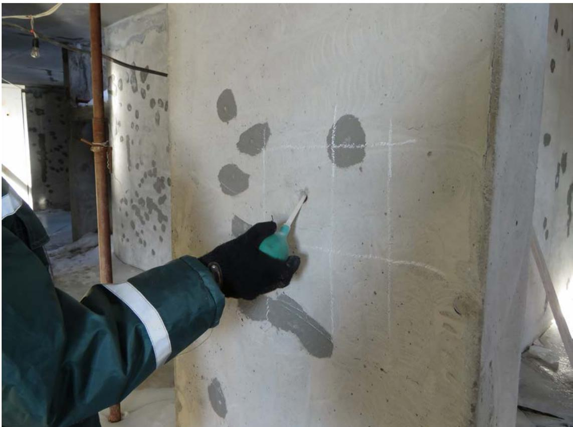
**Рис. 4.2.6. Продувка отверстия от пыли в монолитном железобетонном пилоне подвального этажа в осях 6/1/С/1.2**
