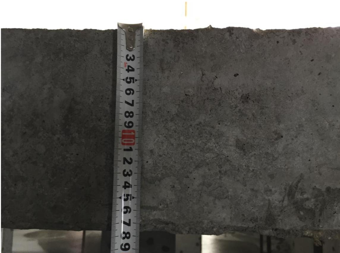
**Рис. 3.3.2. Замер высоты сечения монолитной железобетонной плиты перекрытия подвального этажа**
