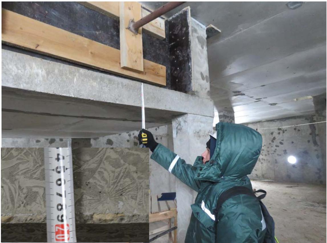
**Рис. 2.2. Замер толщины монолитной железобетонной лестничной площадки**
