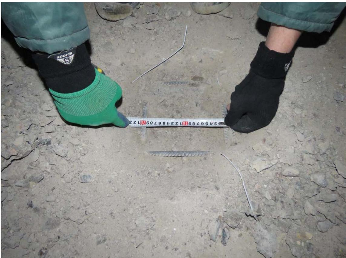
**Рис. 3.1.6. Замер шага верхнего армирования фундаментной плиты между осями 2/3-3/3 и А/3-Б/3**
