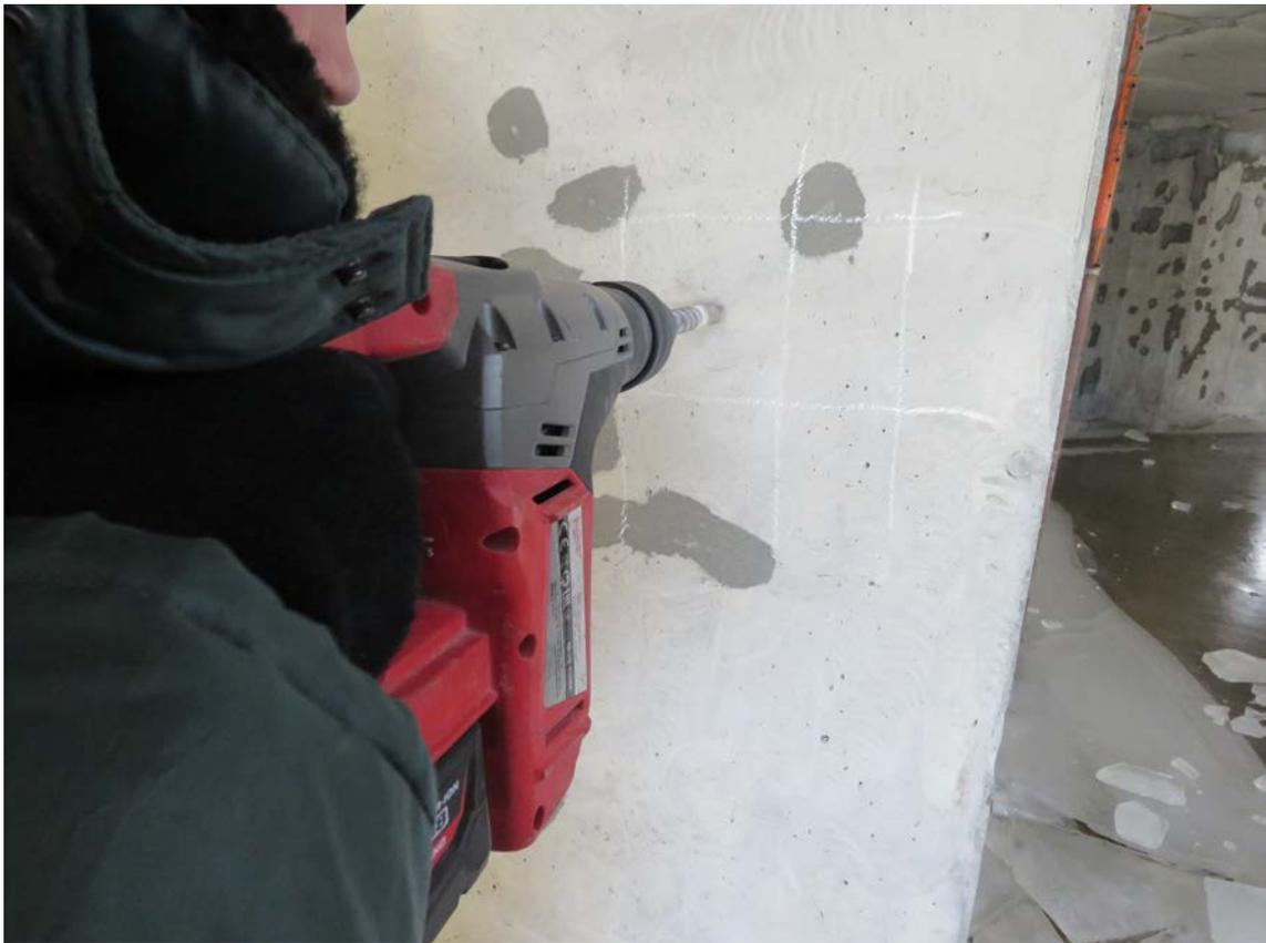
**Рис. 4.2.5. Сверление отверстия в монолитном железобетонном пилоне подвального этажа в осях 6/1/С/1.2**
