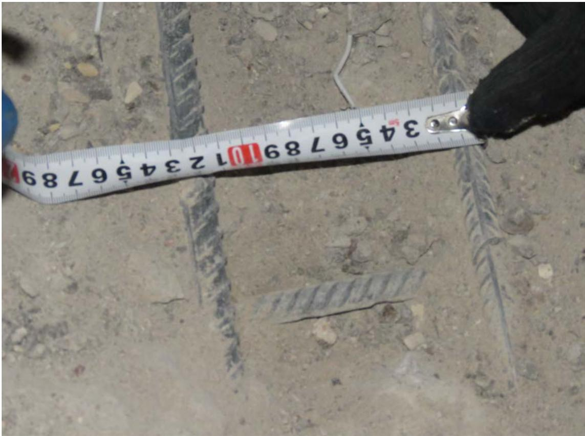
**Рис. 3.1.7. Замер шага верхнего армирования фундаментной плиты между осями 28/2-29/2 и Г/2-Е/2**
