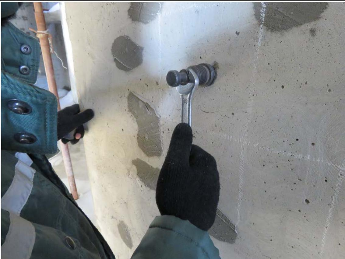
**Рис. 4.2.7. Установка анкерного устройства и тяги в отверстии монолитном железобетонном пилоне подвального этажа в осях 6/1/С/1.2**
